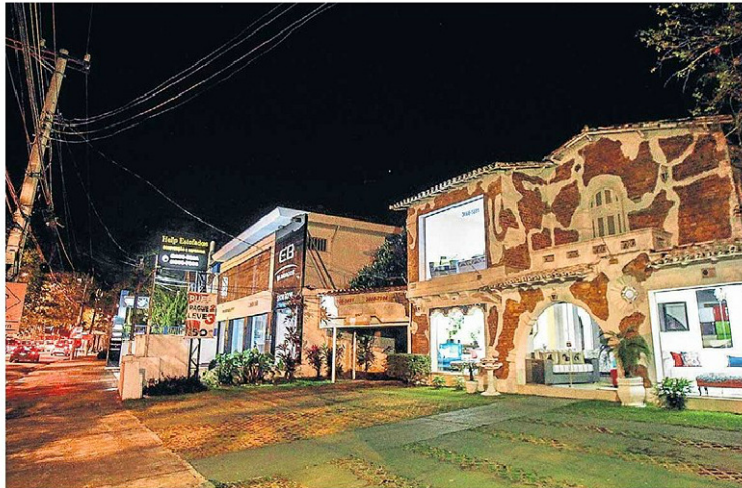
Restrição. Proposta de Haddad mantém proibição de prédios com mais de 10 metros de altura na Avenida Pacaembu
